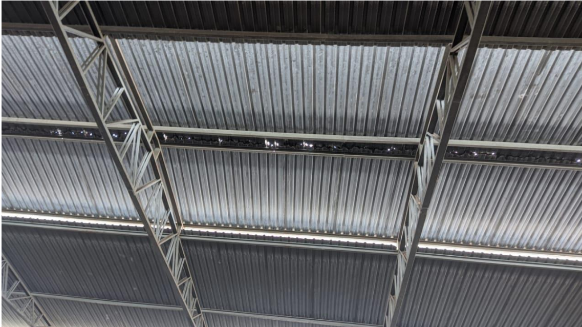
FOTO 5 – Cumeeira de telha metálica que será substituída.
