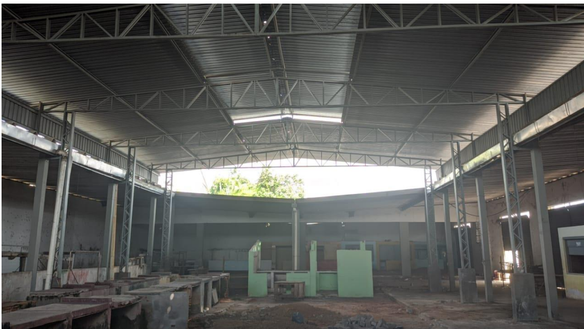
FOTO 6 – Vista da estrutura metálica
