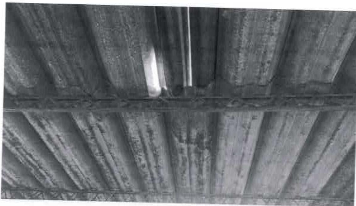
FOTO 4 - Telha de fibrocimento danificada
