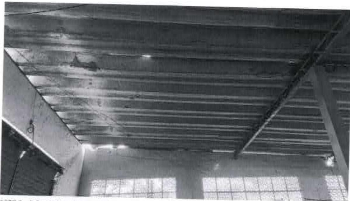
FOTO 2 – Telha de fibrocimento danificada
