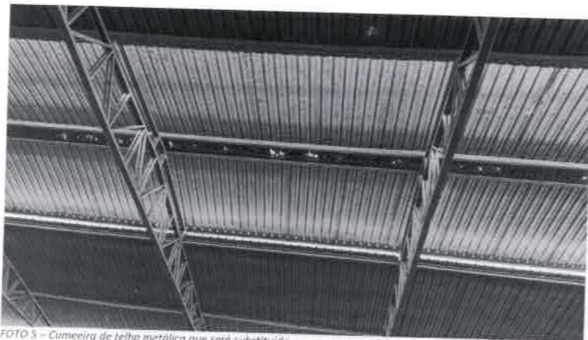
FOTO 5 - Cumeira de telha metálica que será substituída.
