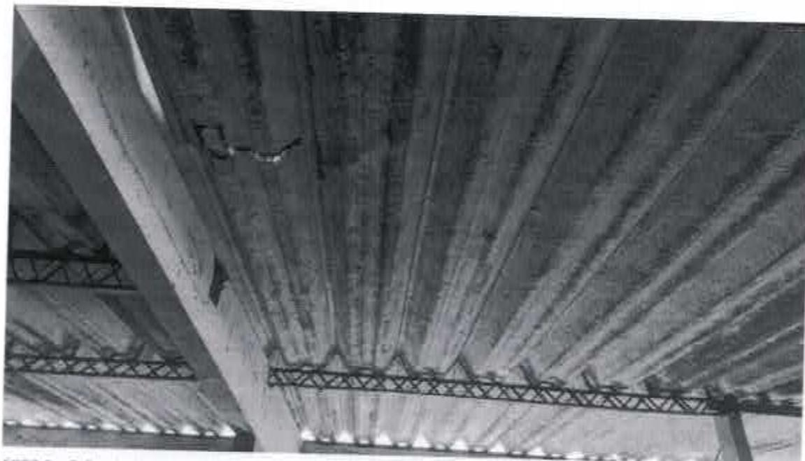
FOTO 3 – Telha de fibrocimento com fissura.
